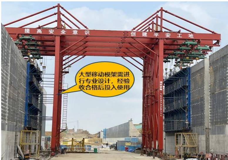
船闸闸室墙施工移动模架
