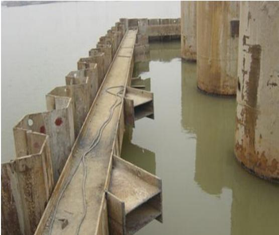
拆除围堰内部支撑杆件
