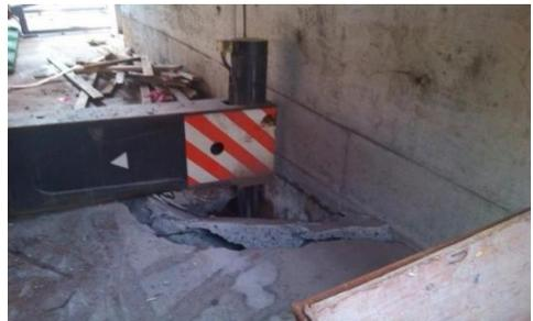
起重机械的地基基础承载力和变形不满足设计要求
