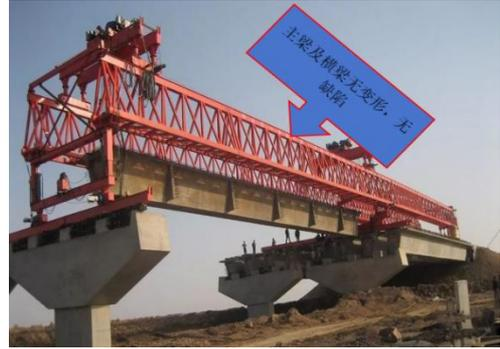
架桥机主梁、支腿、横联及起重天车结构等主要受力构件有严重变形、焊接缺陷、开裂和严重锈蚀等现象
