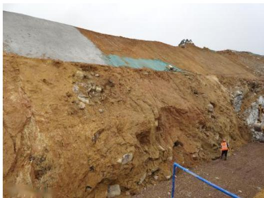
放坡开挖，坡率过大，坡体坡面未修整
