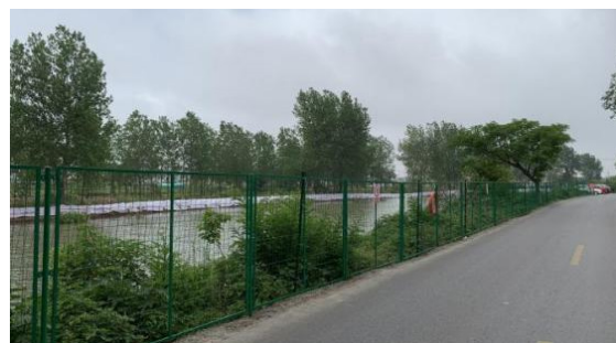
抛泥区封闭围挡
